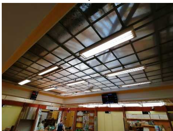
1.NP - problematický hlavní světlík - při prudkých deštích propouští vodu
